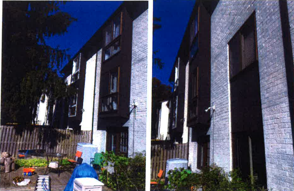
Patio Door Modification
