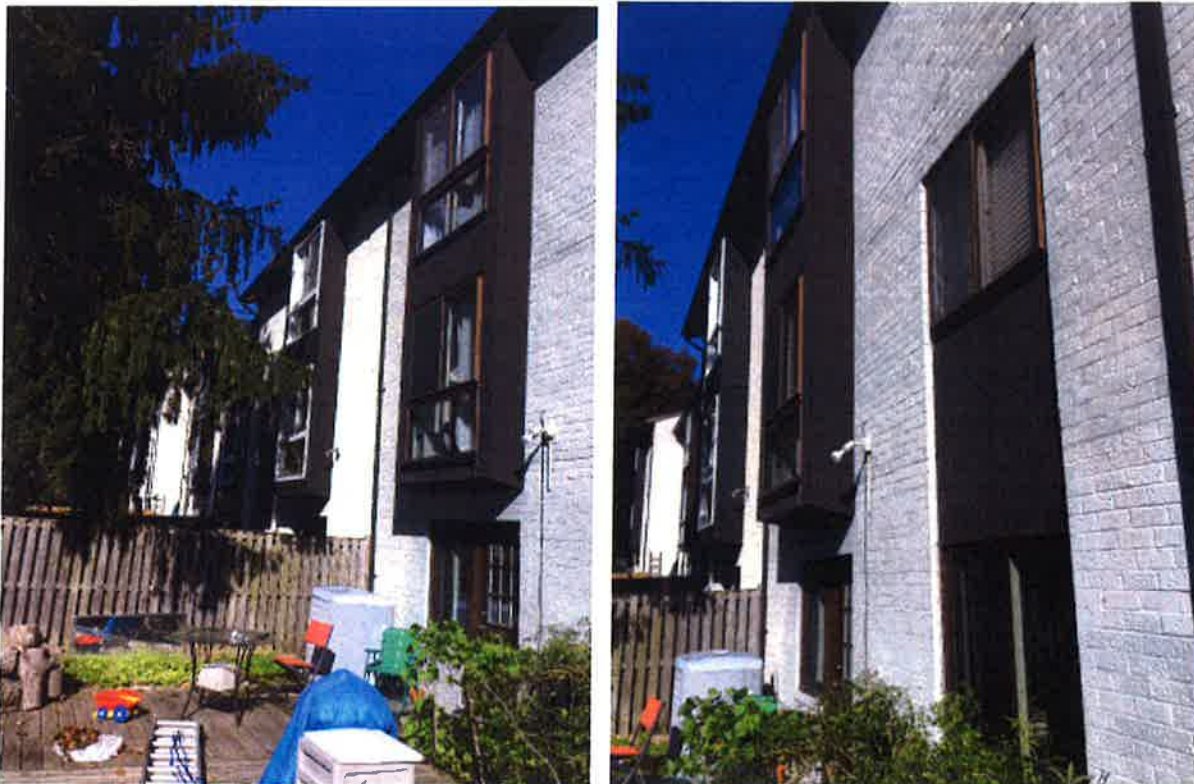
Patio Door Modification
